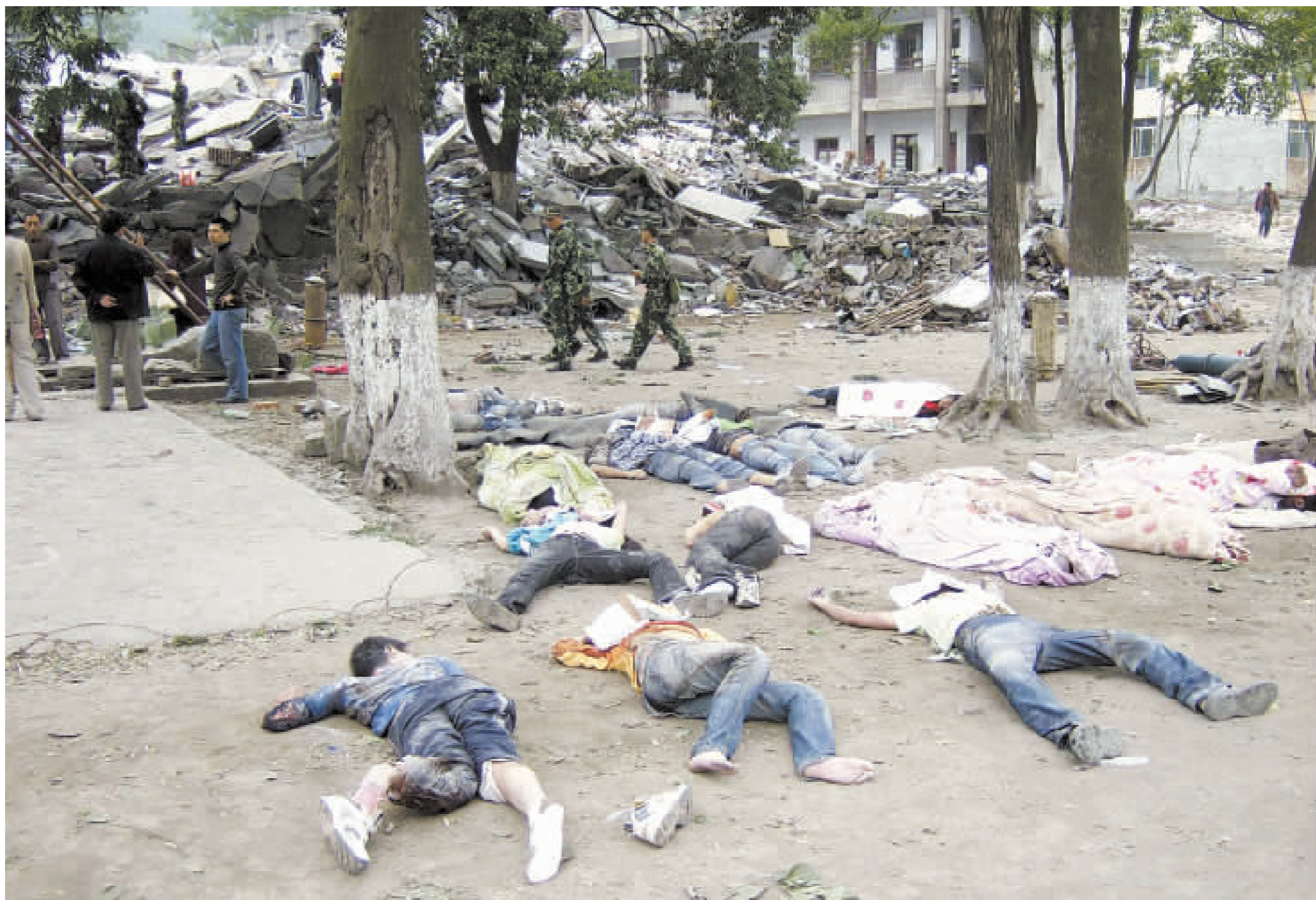
北川中學主教學樓塌陷，師生死傷慘重。
