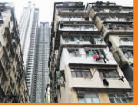
土瓜灣不少舊樓(右上及下圖)水渠無人打理，有的甚至出現大型裂痕。當地很多居民希望強拍門檻降低後，加速這一帶的改造。
