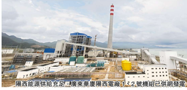
陽西能源供給充足。廣東華廈陽西電廠1、2號機組已併網發電。
