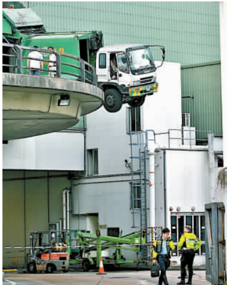
肇事垃圾車車頭撞毀天橋圍欄半天吊。一，同時安排吊車和拖車用鋼纜把垃圾車固定，再拖回安全地方。
