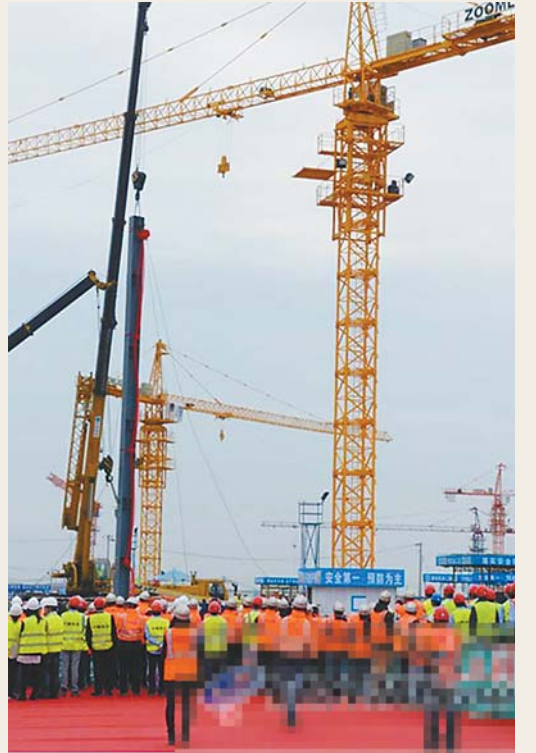
上海迪士尼樂園地上建築施工昨日開始。
