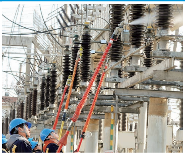
天氣降溫導致負荷攀升，電力企業工程技術人員在江蘇儀征帶電清掃設備，確保電網安全供用電。新華社
