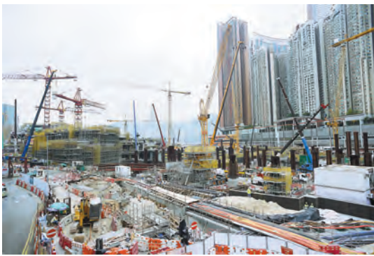
高鐵西九龍總站工地。
