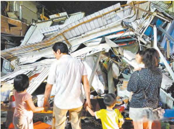
林姓居民的住家已變成一片廢墟。
