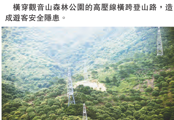
橫穿觀音山森林公園的高壓線橫跨登山路，造成遊客安全隱患。
