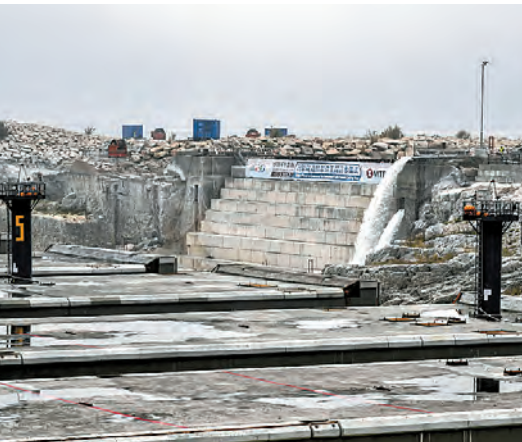
沉管隧道預製件工場會由即日起注入海水。預製件會在2個月後浮起，後逐一拖出維港海床沉放及接駁。
