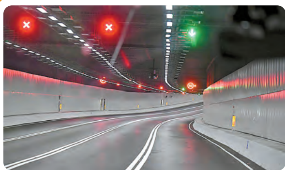
觀景山隧道使用鑽爆法。
