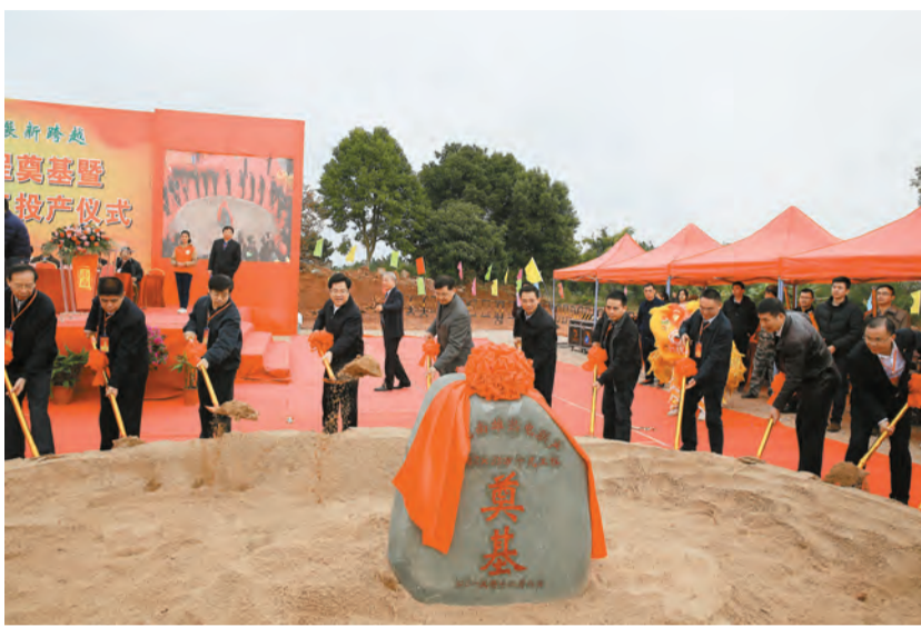
華電南雄熱電聯產工程奠基培土。
